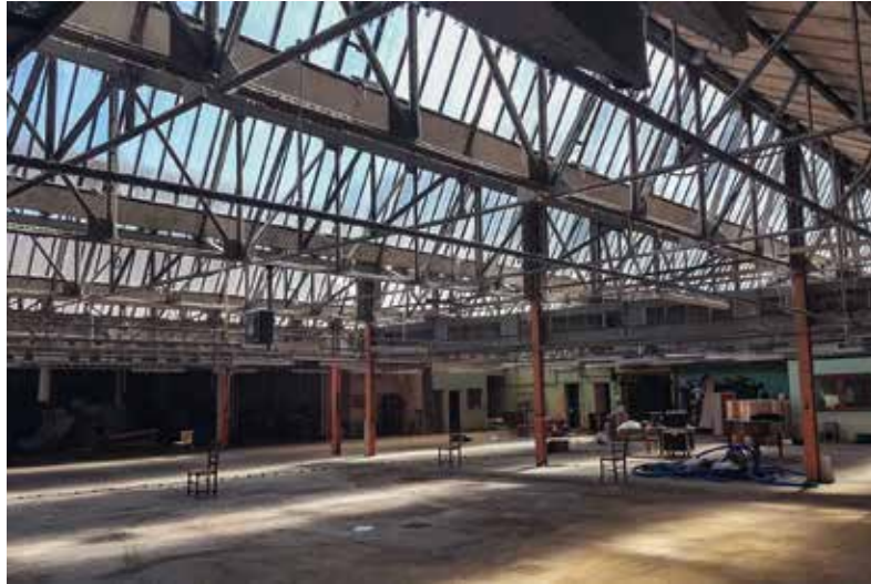
À Saint-Laurent en Royans, l'acquisition d'une ancienne usine de tissage permet d'offrir un vaste espace pour différentes initiatives locales.
