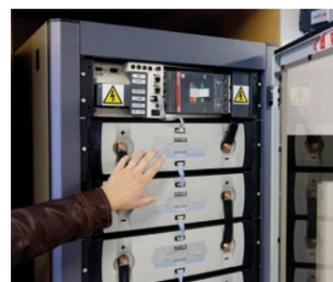
Assemblage de modules Batterie Lithium-ion
