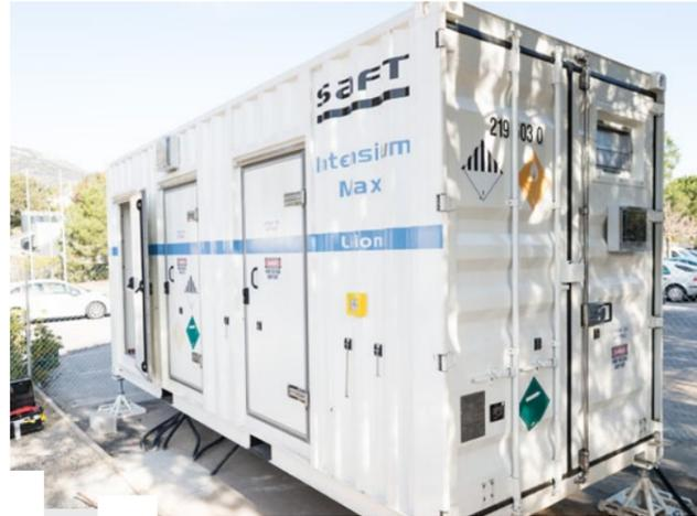
Ces batteries participent aux trois champs d'expérimentation depuis plus d'un an : l'effacement, la gestion de la production photovoltaïque et l'ilotage. Ce système de stockage peut injecter jusqu'à 1,5MW de réseau, soit l'équivalent en appel de puissance de 750 foyers résidentiels lors des pics de fortes consommations en hiver.
